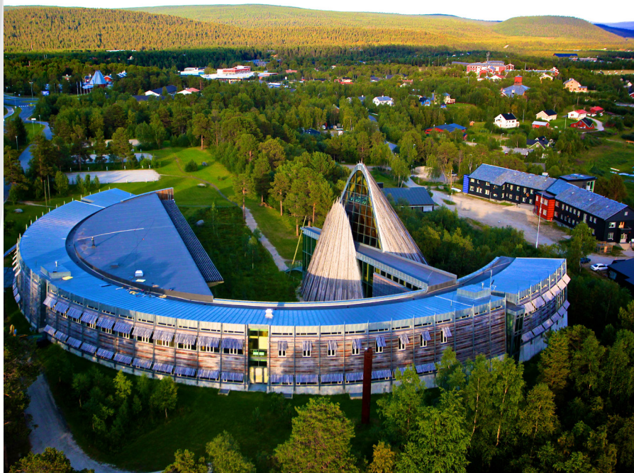
Sametingsbygget i Karasjok
