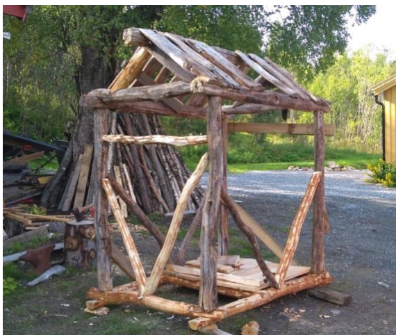
Vi bearbejdet materialene, og satte opp bygget på Stonglandseidet på Sør-Senja før vi tok det ned igjen, og flyttet det til Kaperdalen.
