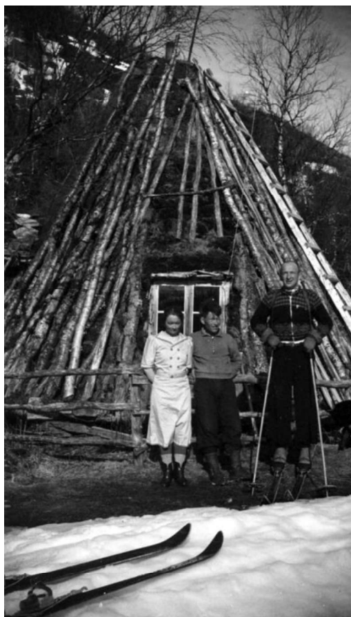
Figur 5. Storkåta i Stavassdalen, Grane kommune. Til venstre på bildet står eierne, Jorg (Georg) og Marie Kvitfjell. Til høyre står Oscar Åsebø. Kåta ble bygd i 1927 av Olaf Andreas Olsen. Foto tatt 1940-42 av Frank Storm Johansen, tillatelse for bruk gitt av Bjørn Storm Johansen.
