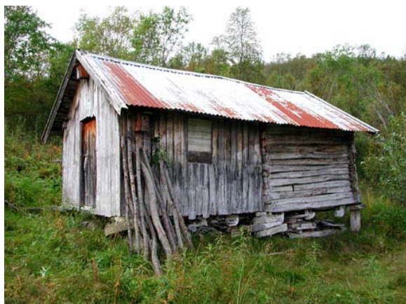
Automatisk freda stabbur lafta av bjørk med lett tilbygg, på Lia i Skjerstad. Den lafta delen skal være 200 år gammel.
