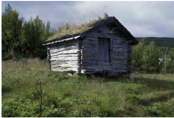
Resursøkonomiske bygninger, stabbur laftet av bjørk, "Borta elven" på Fjellheim i Plassje (Røros).
