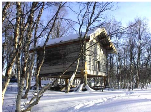
På dette buret på Gråhpoe (Fjellheim) i Aarborte (Hattfjelldal) er skiftet syllstokker, stolper og lagt nytt tak. Det må utvikles opplæringsprogrammer for håndverkere.
