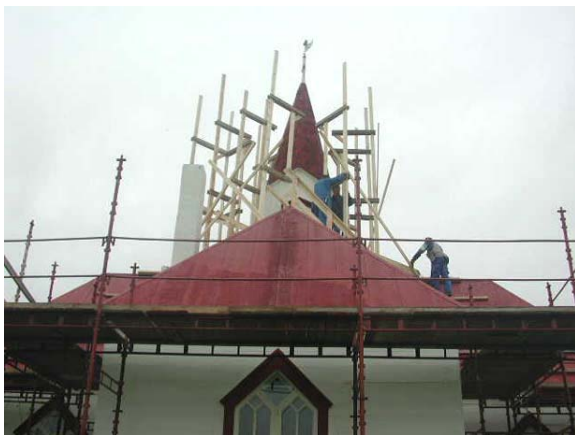
Bygging av stillas for reparasjon av Kárášjohka kirke fra 1807. Håndverksarbeidet på slike verdifulle byggverk må gjøres etter antikvariske prinsipper.
