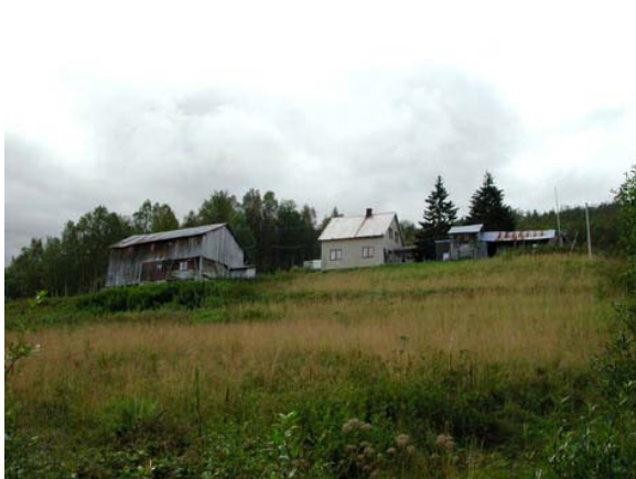
Lia gård i Skjerstad kommune, i bruk som fritidsbolig, bebodd fast til 2000. Gården har automatisk freda hus og nybygd bolig fra 1961
