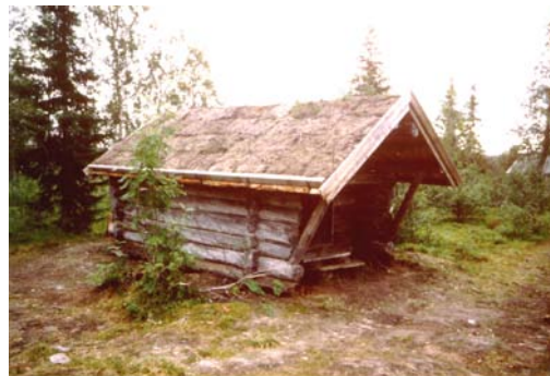
Restaurert stabbur på sommerboplassen Jobkegaske i Røyrvik kommune.
