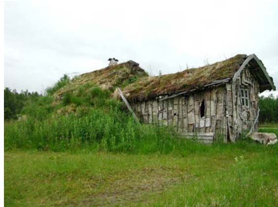
Gammen på Gahpervággi (Kaperdalen) Sápmá (Senja) med nevertékåte vegger i feaskir (bislaget). Begge disse byggverkene var ganske ødelagt da restaurerings- og rekonstruksjonsarbeidet startet på 1980-tallet.
