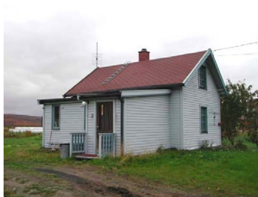
Den automatisk freda boligen i Sirbmá, Deatnu (Tana) er etterisolert og i bruk som bolig.
