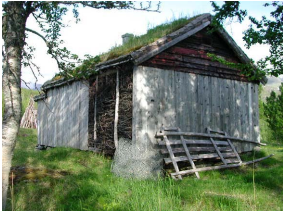
Høysjåen på Vilgesvárri Skánik (Skåne) med ristekåte vegger.
