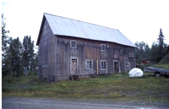
Fjøset på Barbo, Lyjmede (Limingen), Raavrevijbke (Røyrvik) fra 1933 er ute av bruk som fjøs. Huset brukes som lager og arbeidslokale for reindriften og vurderes til nye funksjoner i forbindelse med bestehold i drifta.
