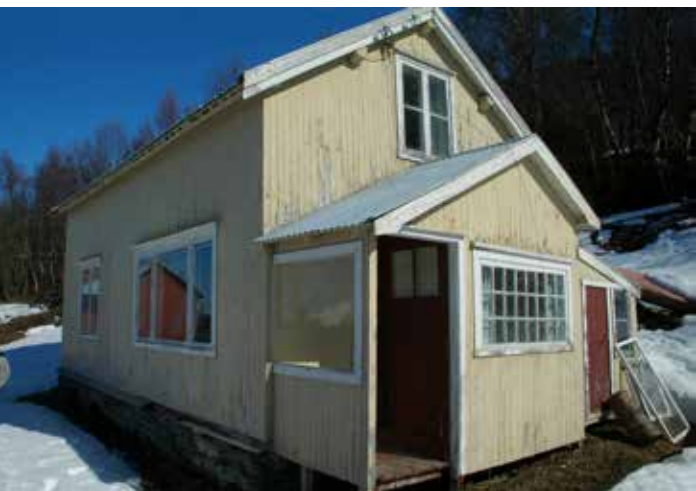
Bolighus i Kåffjord. Det ble gitt dispensasjon for rivning av et yngre tilbygg og oppføring av et nytt tilbygg. Dispensasjonen omfattet også andre endringer på tak, takrenner, hovedbjelkelag, isolasjon og pipe, dessuten noen nye vinduer.
